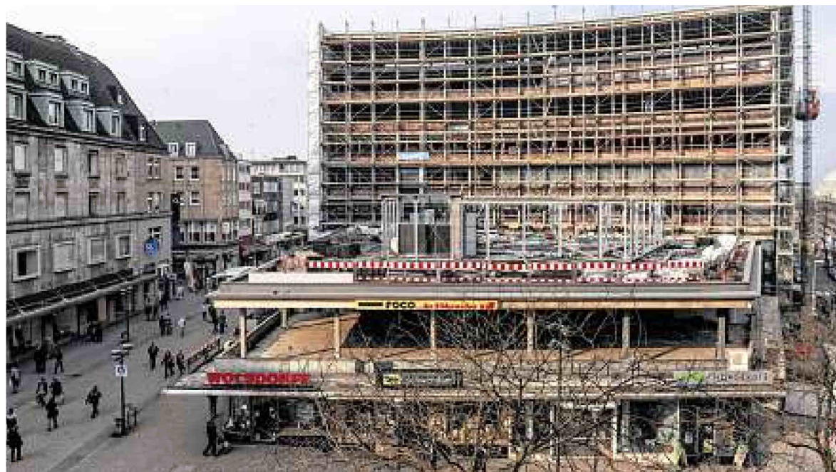
Verheißungsvolle Baustelle; Der Umbau am Kettwiger Tor soll das Entree der Kettwiger Straße aufwerten. FOTO: KNUT VAHLENSIECK
