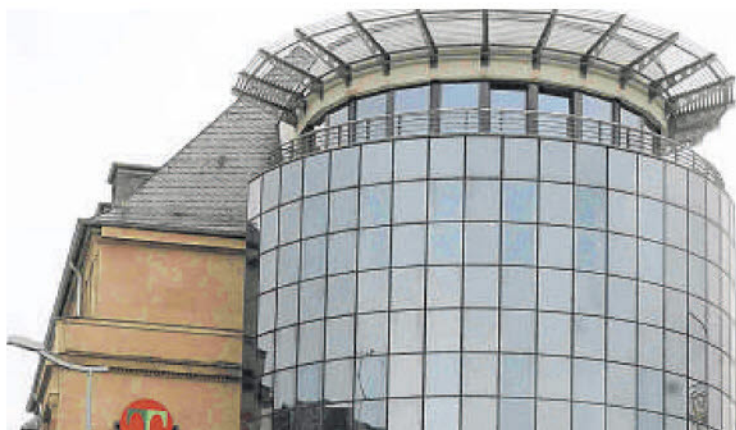
1923 m 2 sind frei im Tengelmann-Haus am alten Stadtbad.
